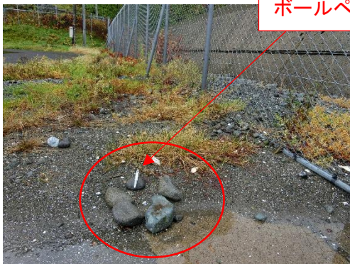
北防波堤基部の状況（越波により砂や石も防波堤を超えて堆積している）R6. 10. 23 撮影
