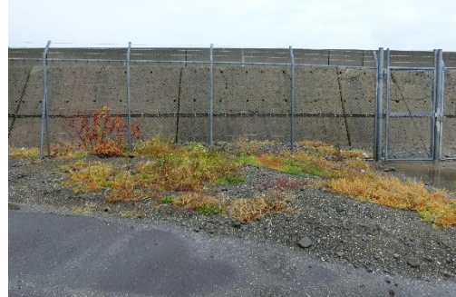
北防波堤基部の状況（越波により砂や石も防波堤を超えて堆積している）R6. 10. 23 撮影
