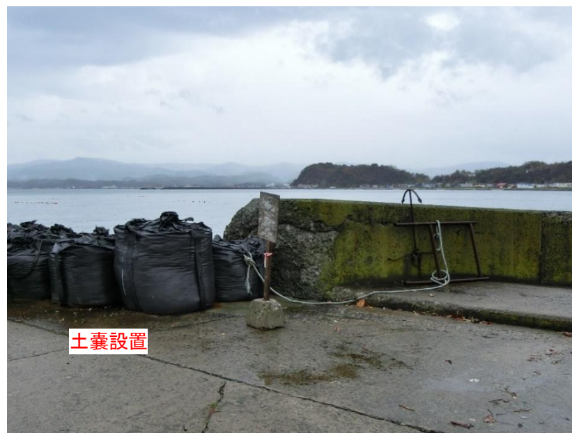
南防波護岸基部の現況
